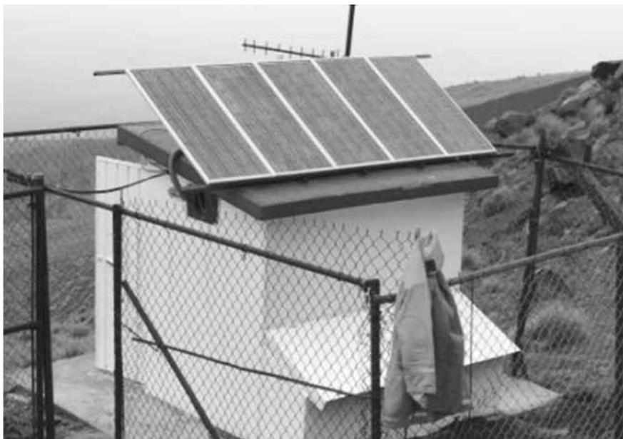
**Figura 4.** Estación sismológica Canario, instalada en el Popocatepetl. Forma parte de la red de monitoreo que opera actualmente en el volcán.
