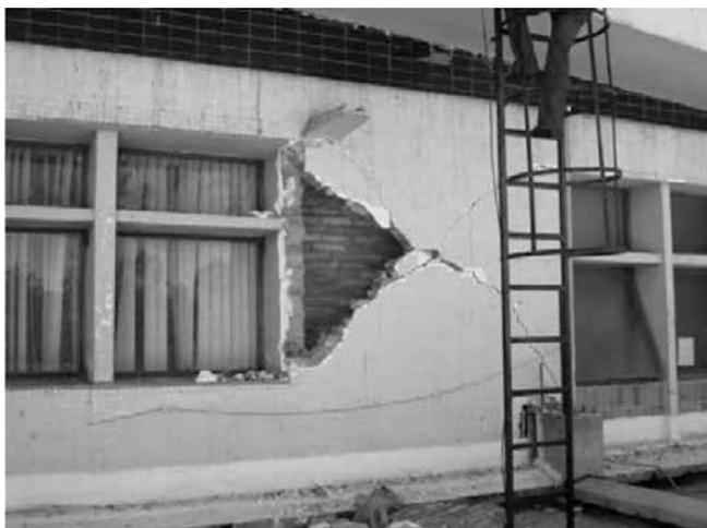
Daño en elementos no estructurales de edificación para hospital, Mexicali, 2010.
